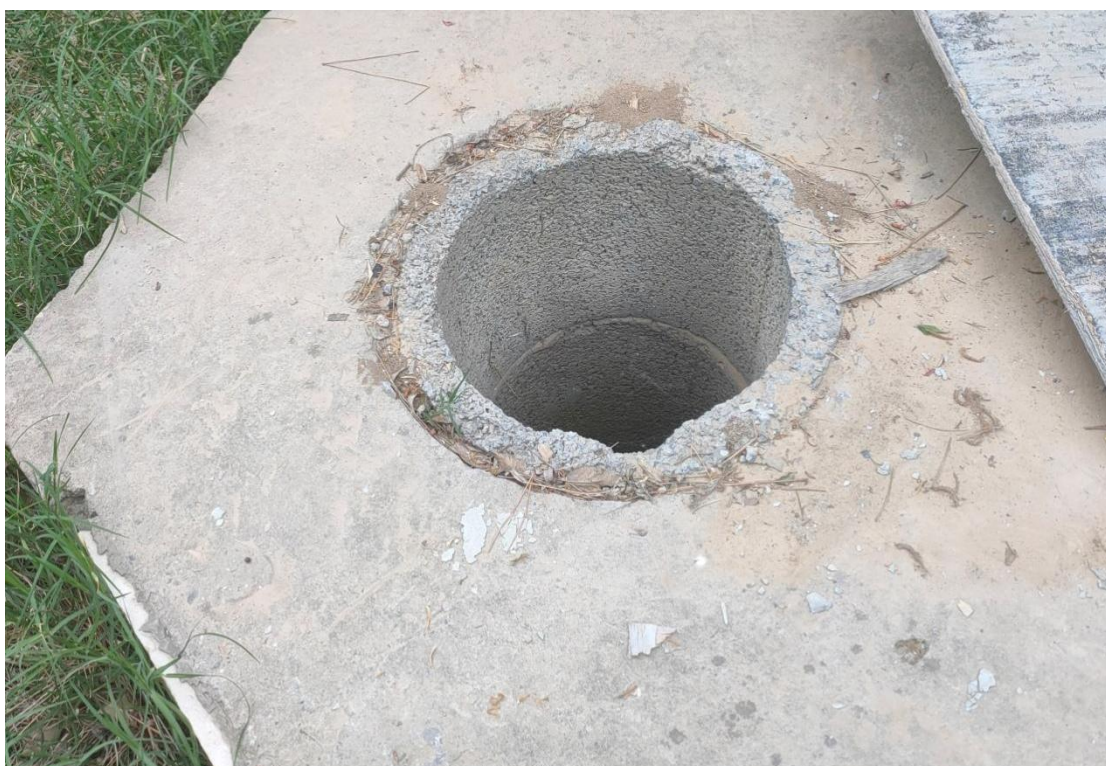
照片 6 机井现状
