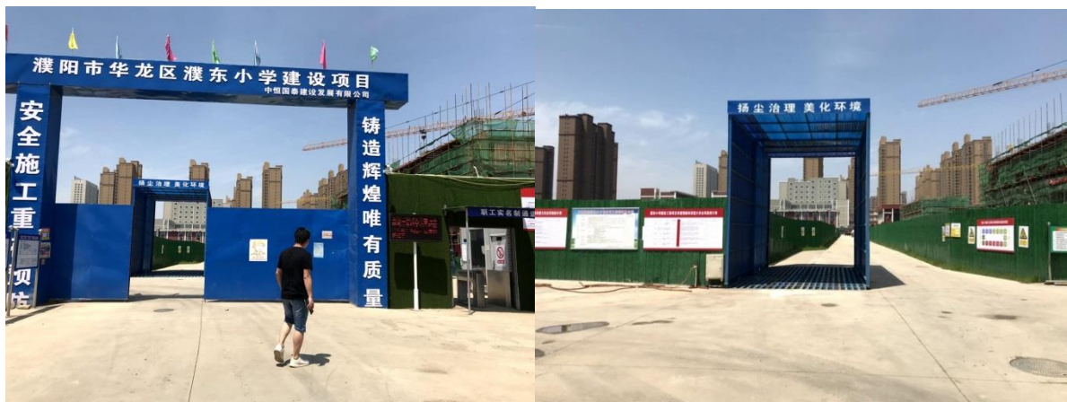
在建项目现状
