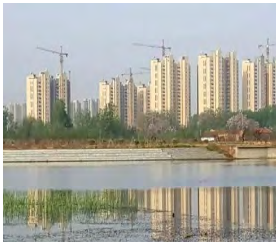
建设中的安置区
